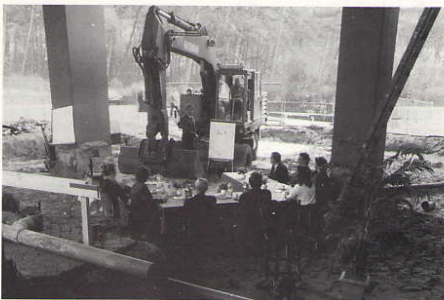
De bouwwerkzaamheden bij het Promenade Hotel
