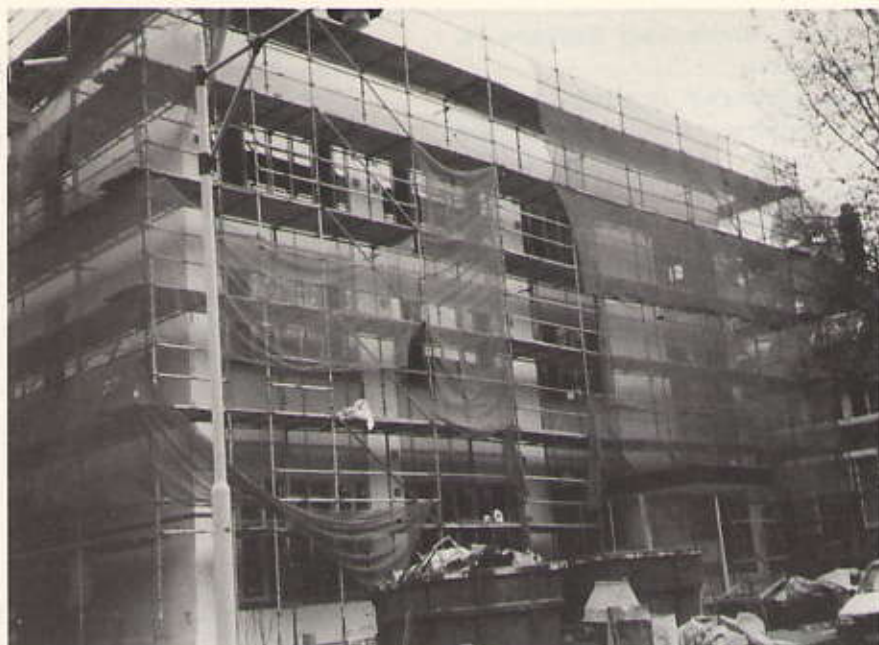
Duinweg 20-22 in de steigers
