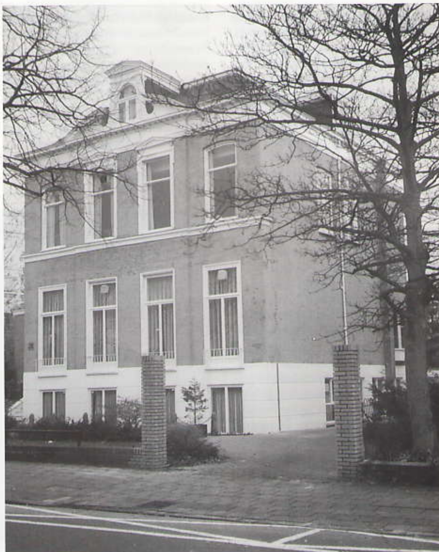
Van Stolkweg 31. Op de voorgrond zijn de voorbereidingen voor het plaatsen van het nieuwe hek al getroffen. (Foto Anneke Landheer).
