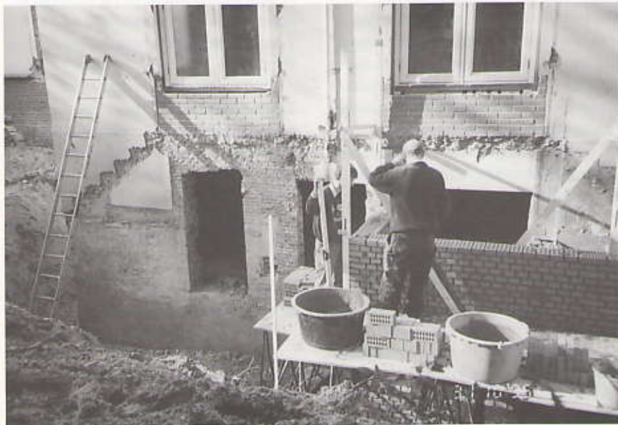
[Bij de Slowaakse ambassade wordt met voortvarendheid gewerkt aan het constructief herstel (Foto Ton Landheer)]
