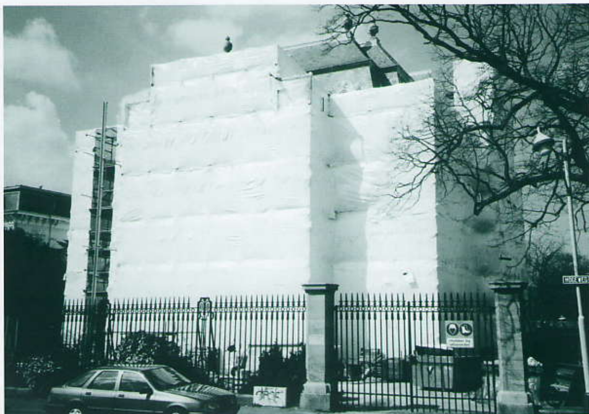
Sandbaghe aan de Hogeweg, toen de restauratie aan de buitenzijde nog niet was voltooid.
