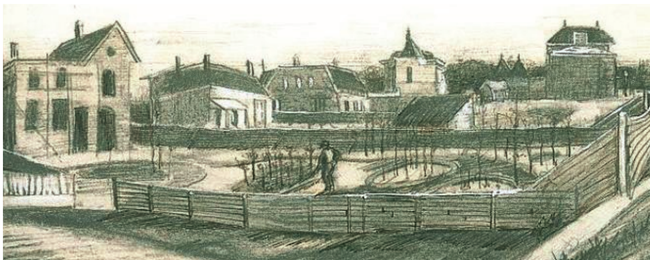
Vincent van Gogh, Van Stolkweg in aanbouw, vanaf de Kanaalweg, maart 1882
