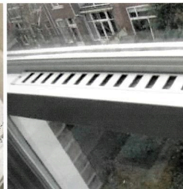
Ventilatioerooster bij wissellat van een schuifraam
